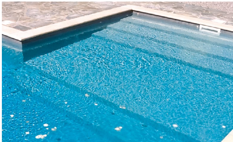
Piscina privata - Città di Castello (PG) (ripristino ultimato)
